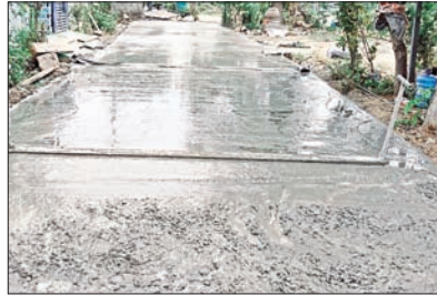
నిర్మాణం పూర్తయిన సిసి రోడ్
